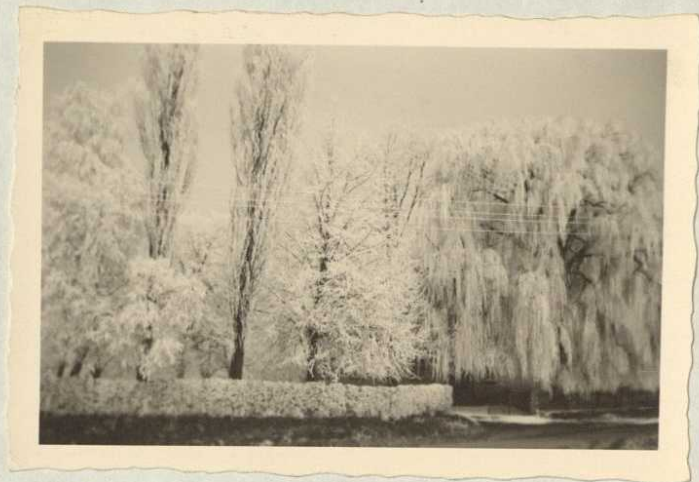
Die Bäume an der alten Schule im winterlichen Kleid
